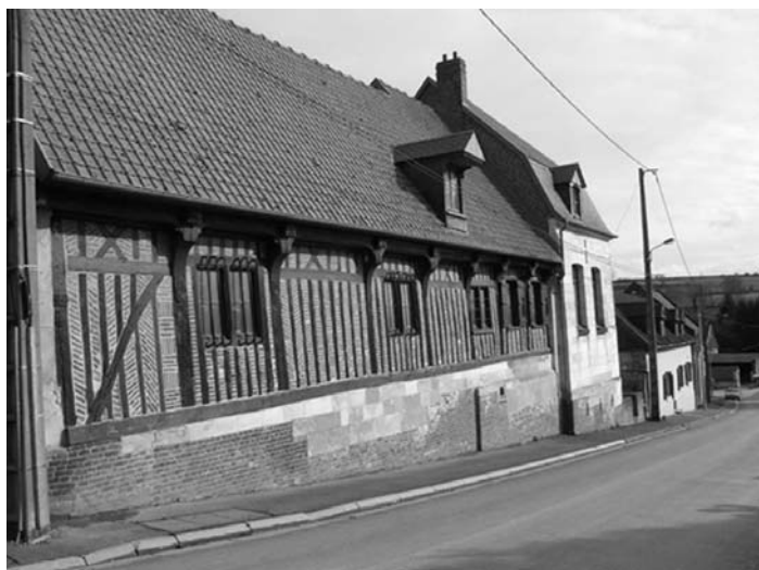
Maison du receveur des Gondi à Paillart
